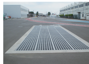
浸水対策（排水口）（宇都宮製作所）
