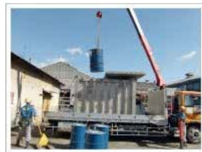
PCB廃棄物搬出作業状況
