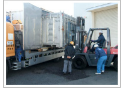
指定容器への収納作業状況
