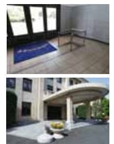
工場内に設置されたスロープ
