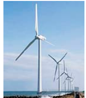
SUBARU80/2.0 ダウンウィンド式風車
