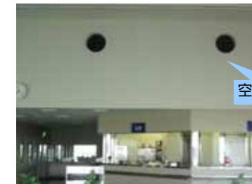
作業改善の例:熱線吸収フィルムを貼った窓ガラスとパワーアップした冷房空調機
