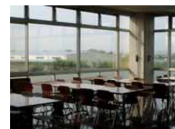
作業改善の例:熱線吸収フィルムを貼った窓ガラスとパワーアップした冷房空調機
