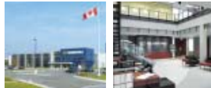
写真10: SCI本社: 自然光を採光した明るい社屋
