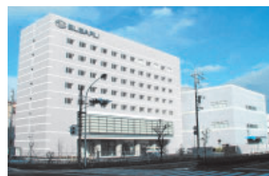
スバル総合研修センター外観
