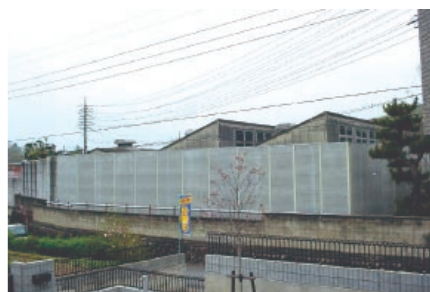
防音塀の設置 （群馬製作所大泉工場）
